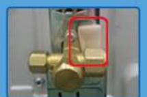
ติดตั้งติกเกอร์ป้องกันในช่องที่กว้างกว่า 4 มม.
